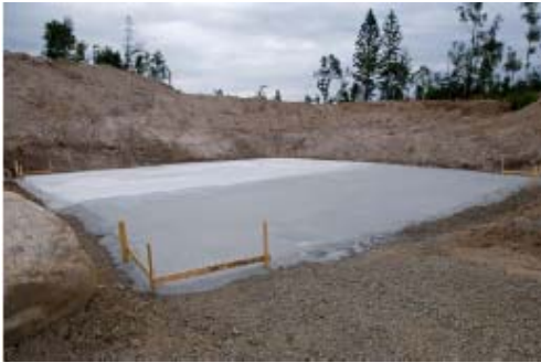
1- Bottom concrete layer
